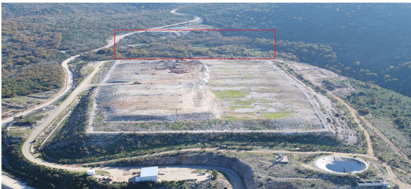
Slika 4. Predviđena lokacija za izgradnju novih sanitarnih kada
