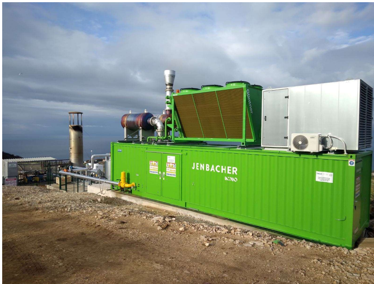
Slika 3. Postrojenje za proizvodnju električne energije na deponiji „Možura“
