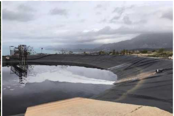
Slika 9: Bazen za sakupljanje ocjednih voda na Možuri
