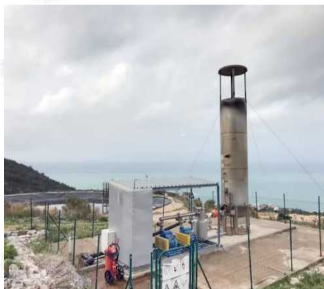
Slika 7: Postrojenje za sagorijevanje deponijskog gasa na deponiji „Možura“
