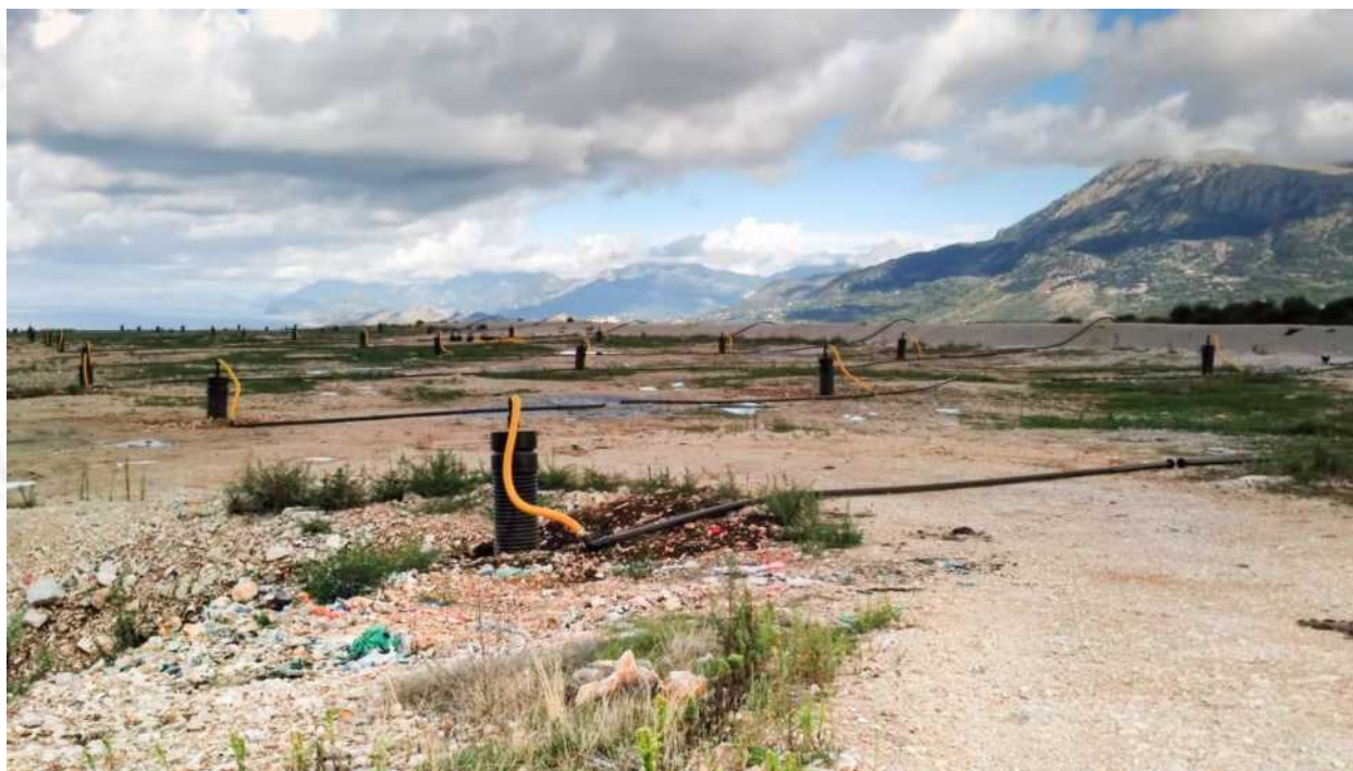
Slika 4: Biotrnovi koji služe da prikupljanje deponijskog gasa
