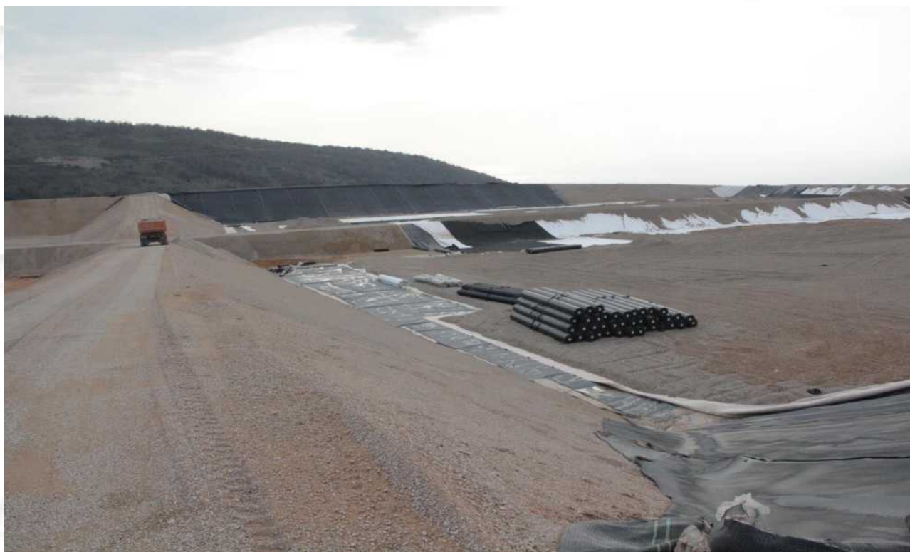
Slika 1: Sanitarne kade u procesu izgradnje
