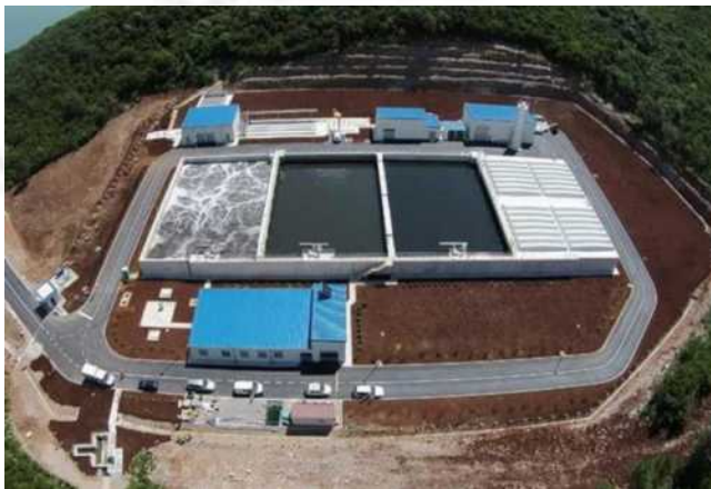
Slika 8: Primjer postrojenja za pre išćavanje otpadnih voda ( postrojenje u opštini Tivat)
