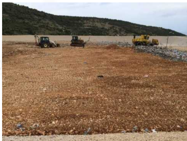
Slika 3: Proces prekrivanja otpada
