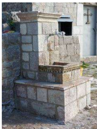
Vodovodna mreža i česma
