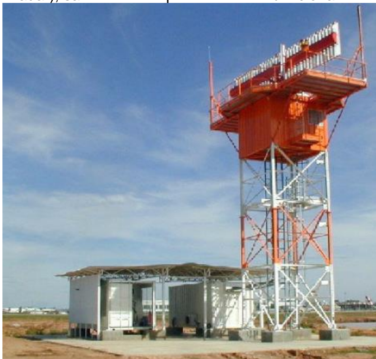
Slika 15 – Primjer instalacije sekundarnog radara RSM 970S Cirius (antena radara je na vrhu stuba, bez zaštitne kupole)
