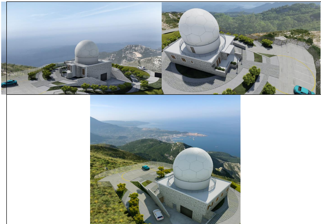
Slika 13 - Izgled fasade objekta Radarske stanice
