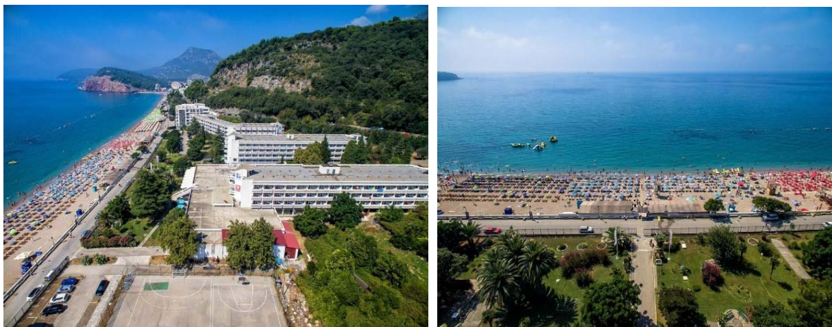
Slike br.2.1 i 2.2. Fotografije postojećeg stanja
