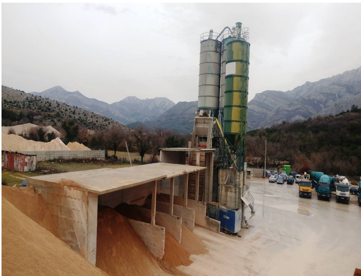
Sl.3.8. Postrojenje za proizvodnju betona
