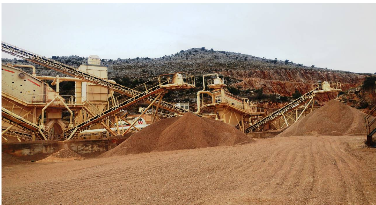
Sl. 3.2 -3.3. Drobilično postrojenje „Goran“
