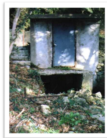
Objekat iznad kaptaže Čanj
