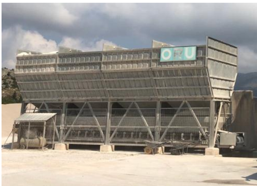
Slika 8. Skladište mineralnog agregata
