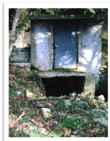
Objekat iznad kaptaze Čanj
