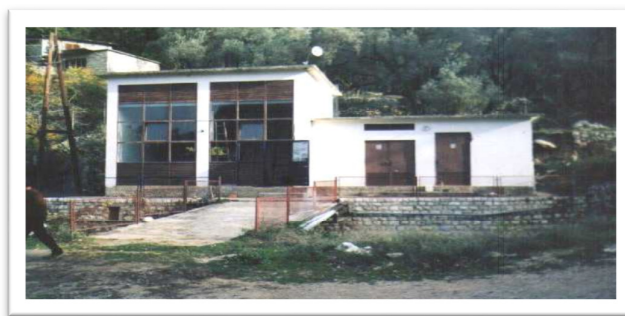
Pogled na objekte iznad kaptaze "Brca"
