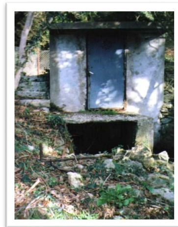
Objekat iznad kaptaze Čanj
