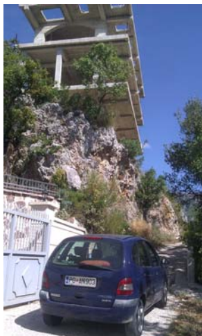
Slika: Objekat u izgradnji u zoni C
