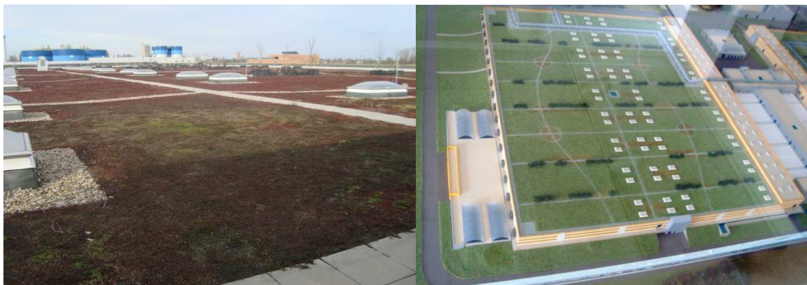
Slika 11.: Primjer ozelenjavanja krova objekta Centralnog postrojenja za tretman otpadnih voda u Budimpešti, Izvor: privatna arhiva
